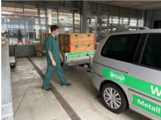
Bild 3.1 Beginn des Umbaus. Alles wurde bereits intern bei Wiap aufgebaut und getestet, erst dann zum Kunden geliefert.
