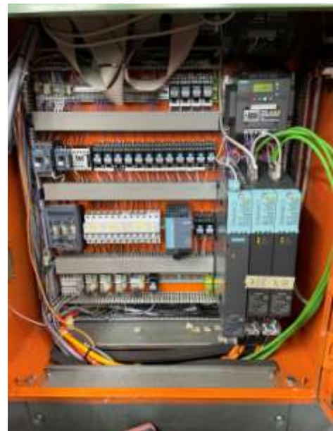
Bild 4.3 CNC nach dem Umbau mit neuer Ware, nachher.
