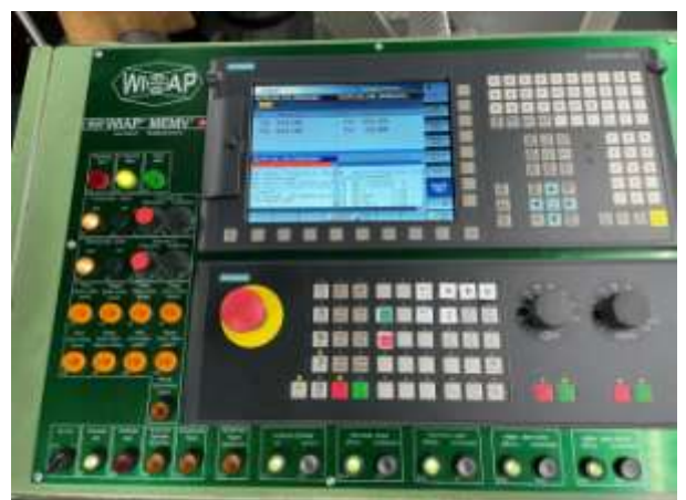
Bild 4.4 Neue CNC nach dem Umbau
