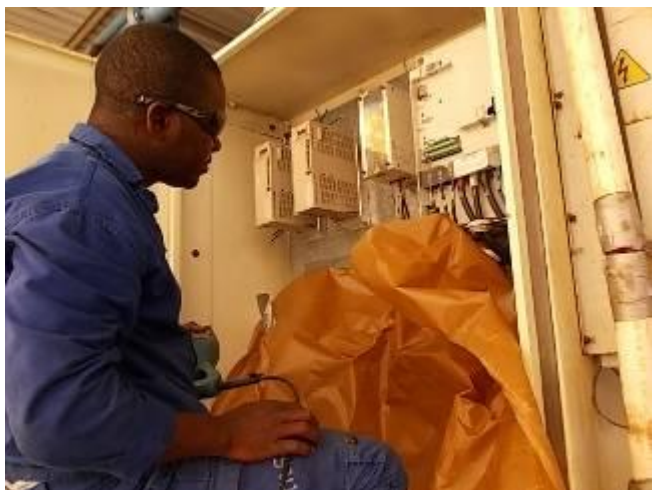
P24) Tivemos que explicar para os meninos quando eles não cobrem a perfuração, pode haver um pop ao girar porque os chips não são permitidos na eletricidade e eletrônica. É por isso que tudo tem que ser coberto durante a perfuração.
