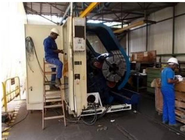
P18) Alberto prepara a instalação.
