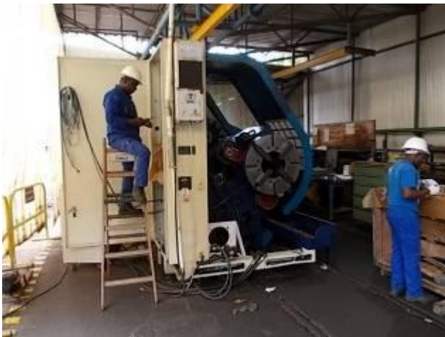
P18) Alberto prepares the installation.
