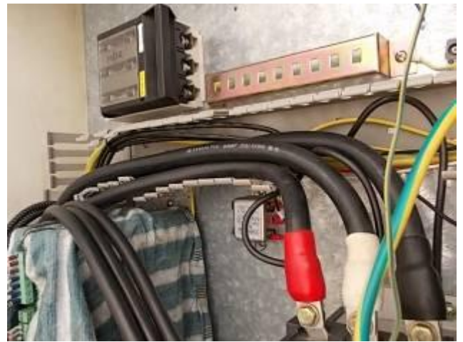
P21) Hier machen wir das Absicherungssystem anders, mehr Absicherungen . Keine dünne und dicke Drähte, ohne Absicherung.
