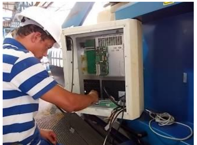
P28) Carlo bereitet die neue CNC Steuerung vor. Wir sind froh, weil sie diese in- und auswendig kennen.
