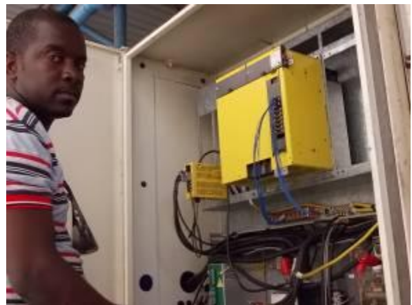
P5) Alberto bei der Vorbereitung des Ausbaus des Fanuc Materials.
