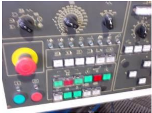
P3) Das alte Fanuc Panel wird ersetzt.
