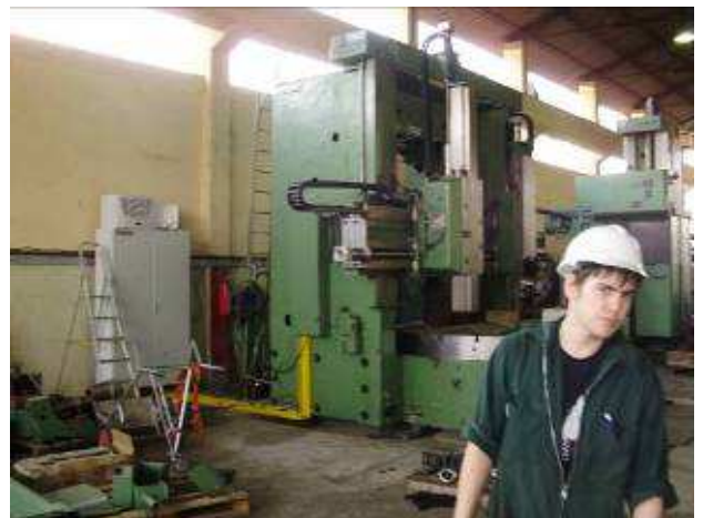
Start der Verkabelungen. Sven Widmer WU_240_220
