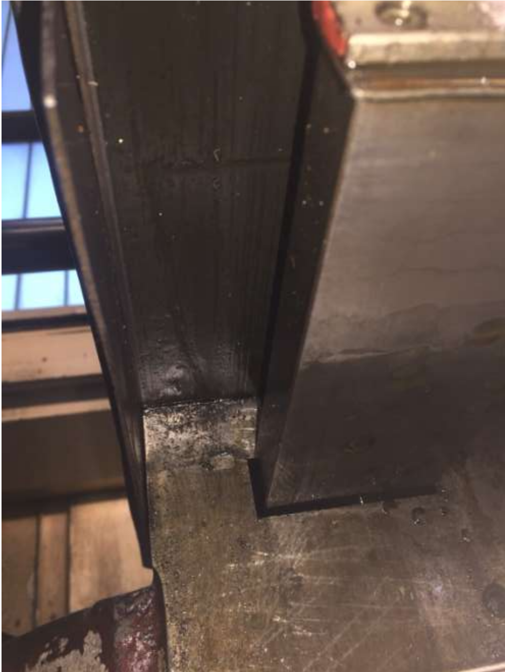
Bild 6: Der Gleitbelag ist ein SKC der wird aufgegossen ist nicht so einfach wie ein Turciten oder Wolf Belage K100 doch etwas aufwendiger wir machten das an einer 150 Tonnen Maschinen Revision auch, Link zu dem 150 Tonnen Projekt
