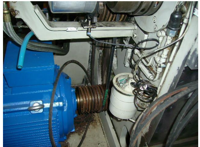
Bild 7: Die alte Riemenscheibe des alten Spindelantriebes kann wieder verwendet werden.
