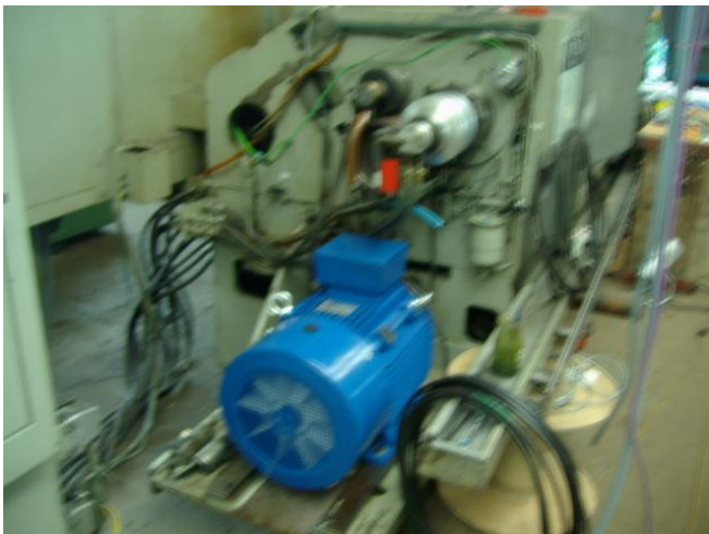
Bild 5: Der alte Hauptspindelantrieb wurde gegen einen neuen 30 KW Antrieb ersetzt.
