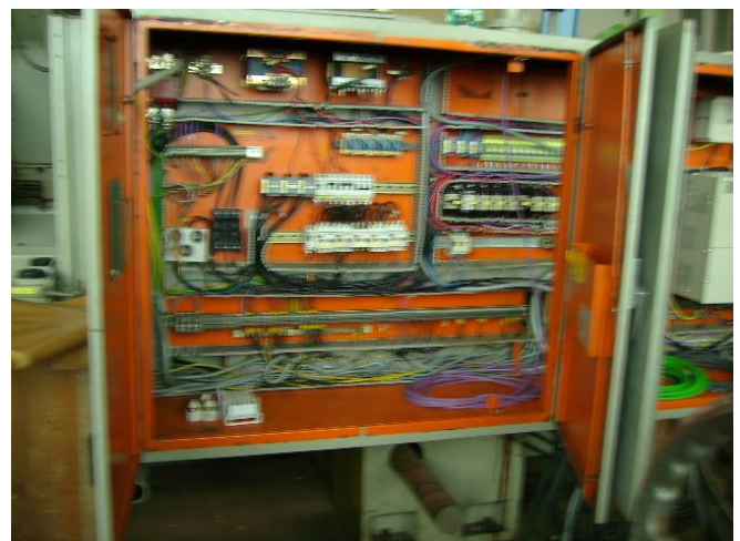
Bild 9: Im Elektroschrank wurde viel Altes ausgeräumt und Neues installiert.
