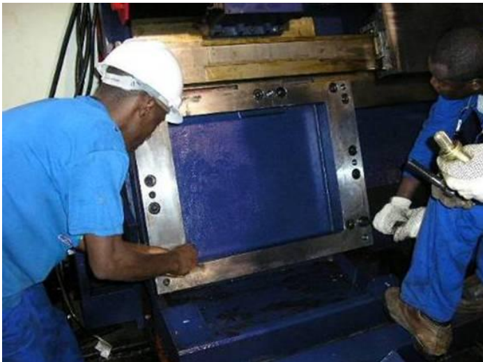
Bild 5: Hier war eine Distanzplatte montiert, welche demontiert werden musste für den grösseren Spindelstock.
