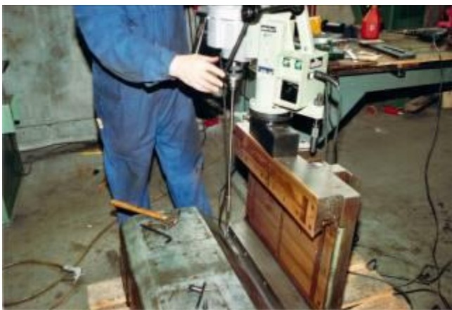
Bild 1: Die Walzendrehmaschine MFD war ca. 40 Tonnen schwer. Der alte Vorschub Getriebe Anteil wurde abgetrennt.
