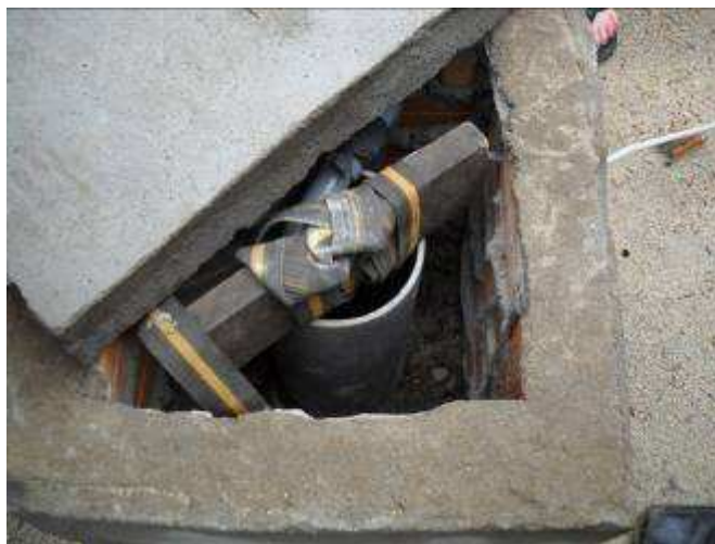
Photo hier das fertige Bohrloch Pumpe schon unten ca. 100 Meter tief
