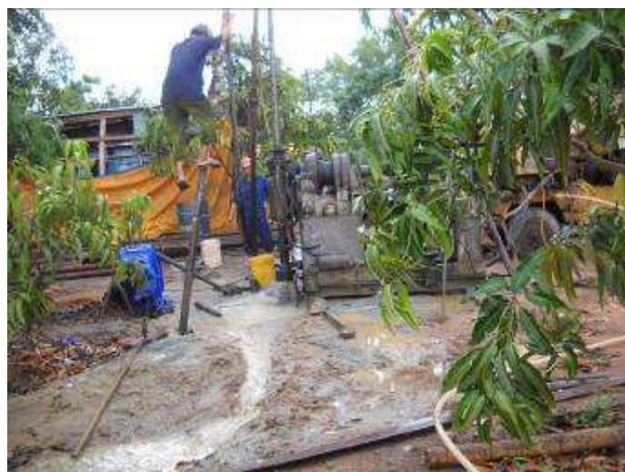
Photo: Mit einer hand voll flinken Leuten bohrt man in 2 Tagen ca. 100 Meter tief.
