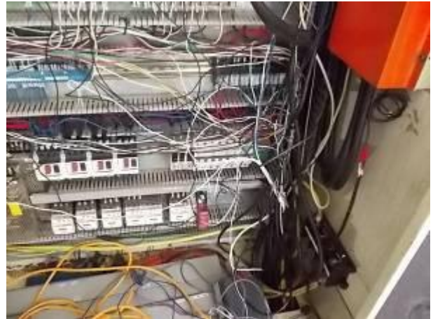
P9) redes mistas e cabo. Surpreendentemente, o fabricante tem a cabeça 0, assim como o poder, feita para o 220 volts com várias cores. Cabos foram muito curto, foram estendidos com cabos de cores diferentes. Alguns no canal a cabo foram soldadas juntos!
