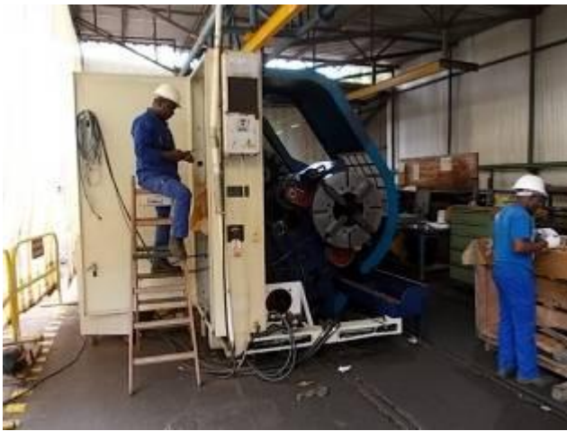
P18) Alberto prepares the installation.
