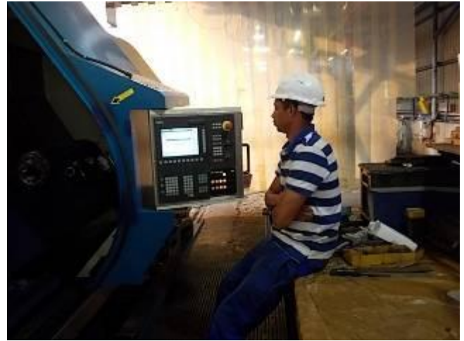
P33) Und schon hat Carlo die CNC eingeschaltet: Wir haben alle 110 Volt vom Panel entfernt und haben nur 24 Volt. Das hat den Vorteil, dass niemand mit einem Stromschlag rechnen muss.
