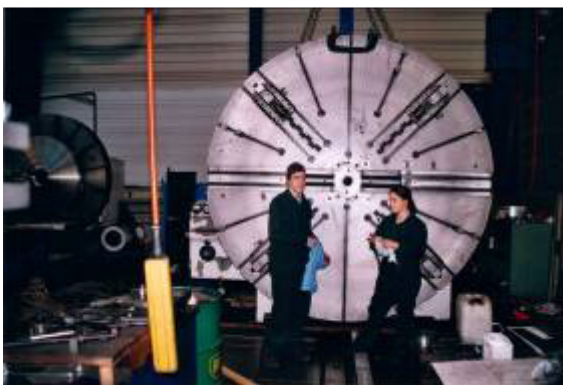
Vorbereitungen zur Demontage nach dem Vermessen der Maschine. WU3270
