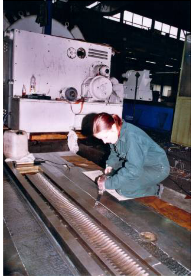
Jetzt wurde der Fehler mit der Schabmaschine korrigiert. In der Regel werden pro Schabdurchgang, je nach Druck, ca. 0.002 bis 0.005 mm entfernt. D.h. wenn ein Fehler im 0.1 mm Bereich ist, muss doch einiges geschabt werden. WU3130
