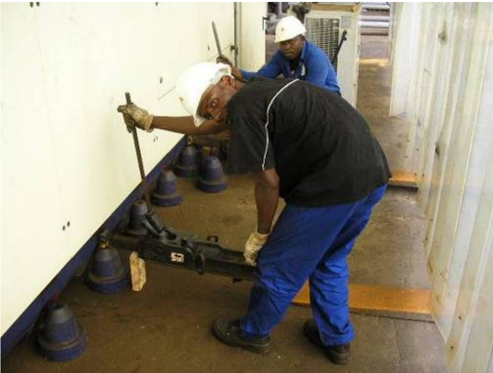
Photo21: Nun hat man mit den 2 Stockwinden die Maschine genau zur Mitte der Eisenbahnschiene platziert.
