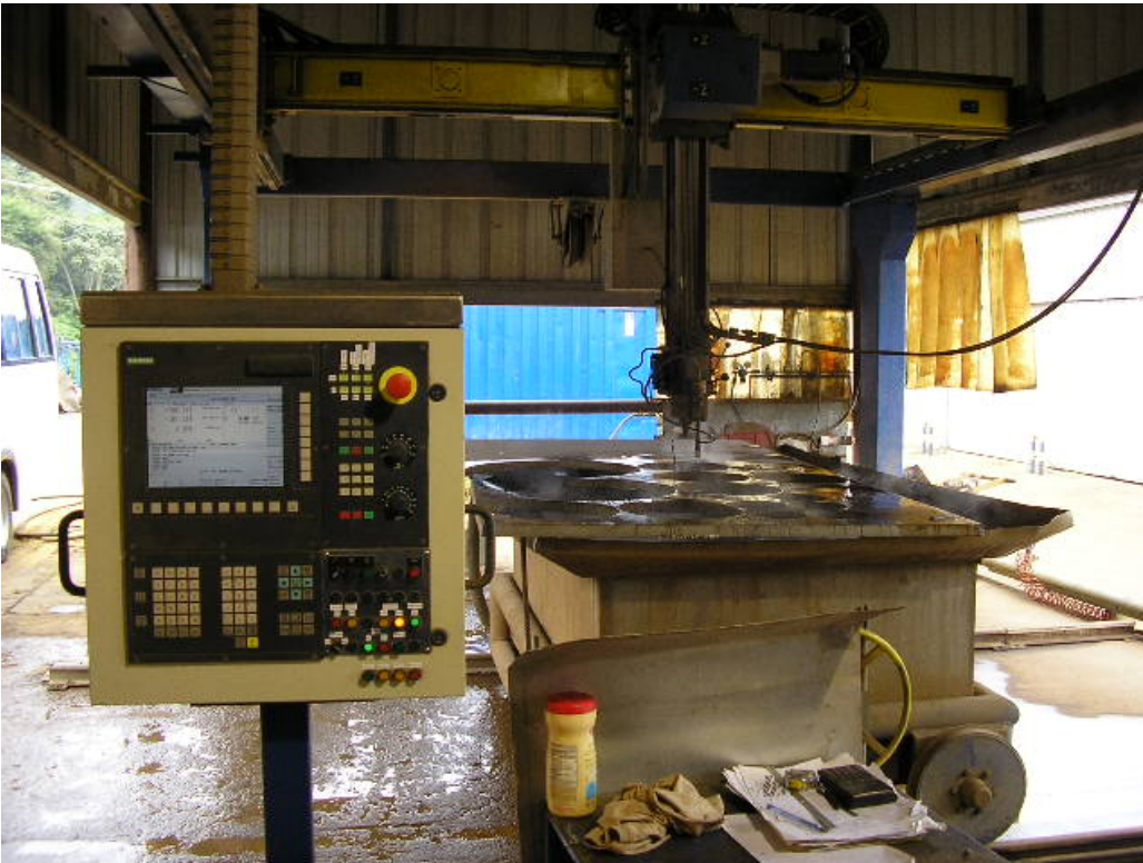
Photo: Hier sieht man die neue CNC Steuerung mit der Wasserstrahlmaschine. Die Anlage steht im Freien. Man muss der Schutz der Elektronik besonders beachten die hohe Luftfeuchtigkeit ist ein grosses Problem.
